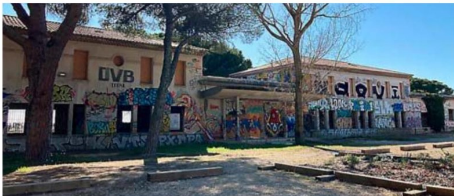
Un bâtiment de 1200 m 2 a été conservé, il y a un an, lors de la démolition du sanatorium.
